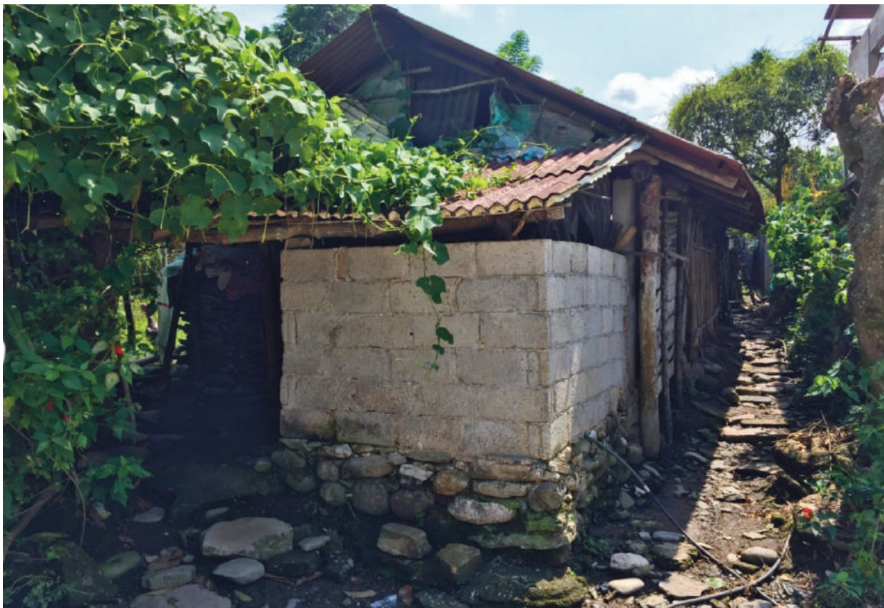
Figura 3.- Materiales de construcción en las casas de san Antonio Rayón, Puebla.
